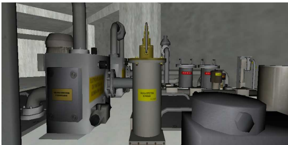
Fig. 2. Imagem virtual da válvula detectora montada sobre o regulador de velocidade
