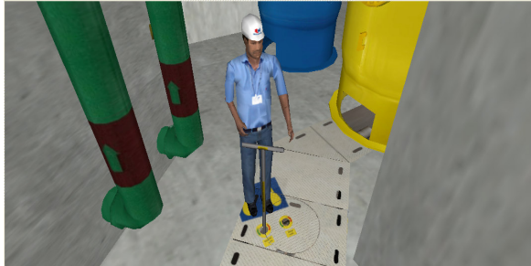
Figura 11. Fechamento da válvula by-pass
