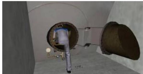
Figura 10 – Mantenedor entrando na caixa espiral
